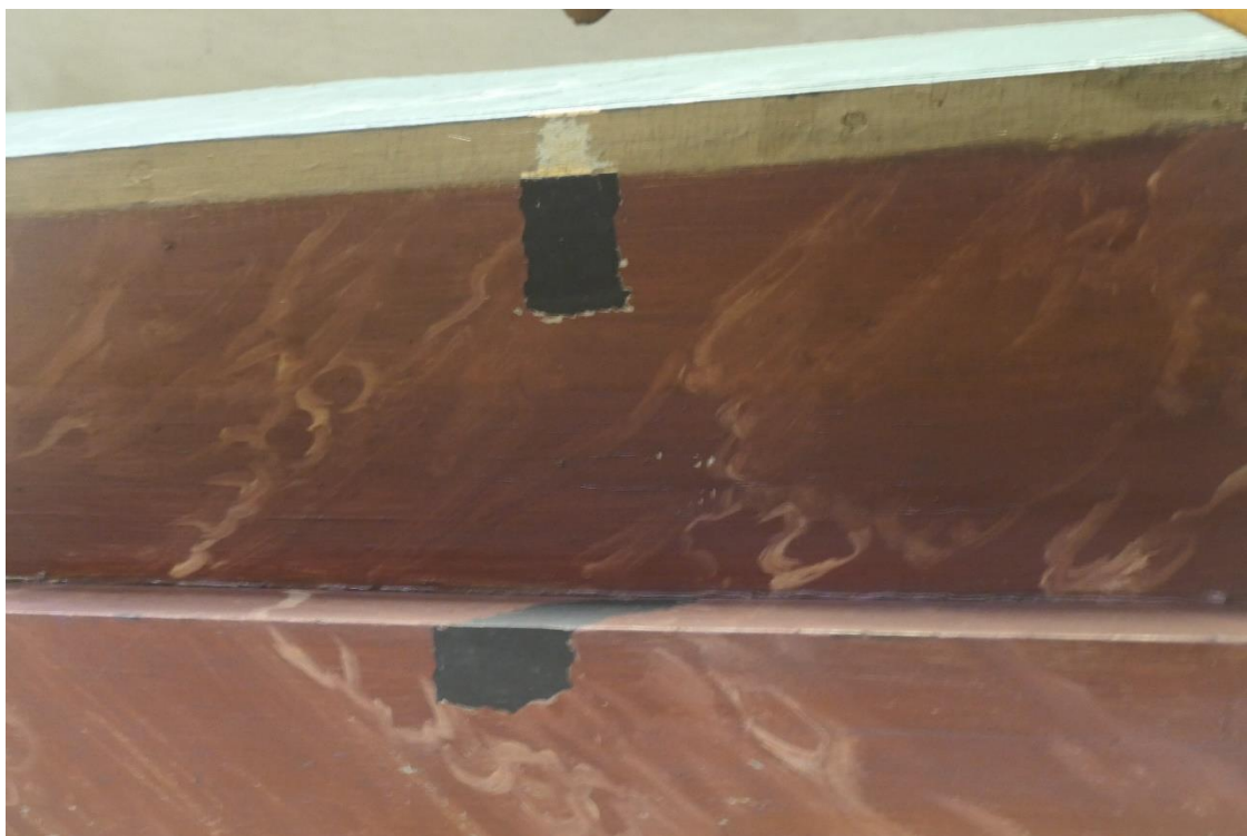
8. Odkrywka na pilastrze.
